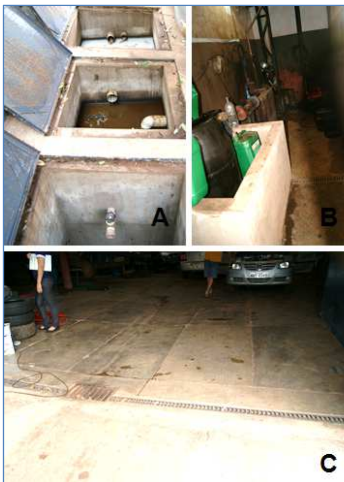
Figura 5. Figura5A (Sistema de tratamento de efluentes construído na empresa), Figura 5B (Sala de lavagem de peças) e Figura 5C (Sistema de grelhas dispostas no portão de entrada da empresa).
